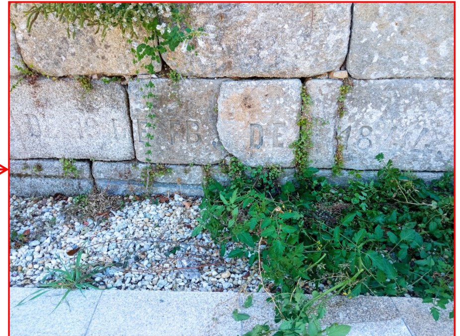
Puente mayor Orense, Diciembre 1844
